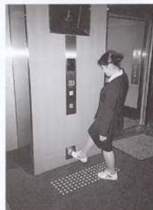
写真4 非常時の対応を考慮したエレベーター
