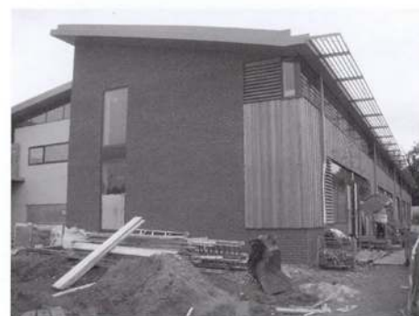
写真1 工事中のTreeHouseの南西部外観
