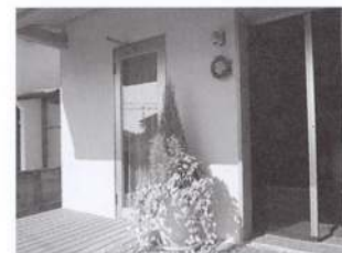
写真4 将来の訪問介護を想定した新築住宅の事例
