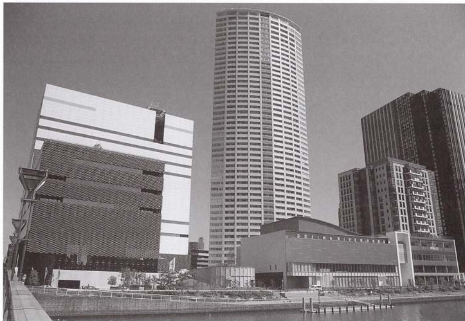
写真1 玉江橋から見たほたるまち全景
