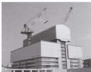
写真10 在来工法との組合せの事例
