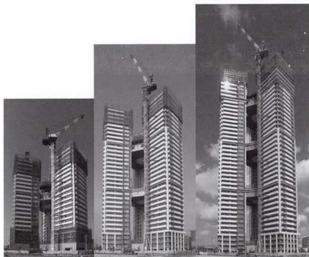
写真1 リフトアップ状況
