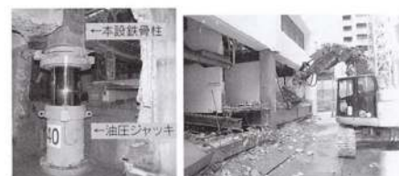
写真2 油圧ジャッキ (1階) 梁床解体 (2階解体作業階)
