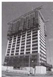
写真4 シャトライズ工法 (鹿島建設)
