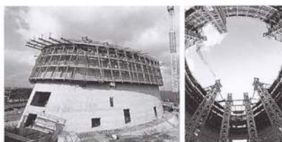
写真3 スリップジャンプ工法施工例
