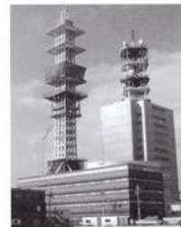
写真4 プラットホーム工事全景
