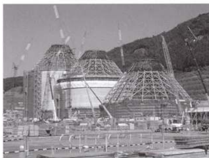
写真2 スリップアップ工法施工例(中央)
