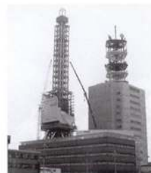
写真3 外周養生解体
