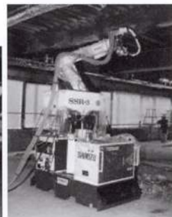
写真3 耐火被覆吹付けロボット
