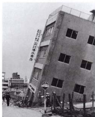
写真1 1964年新潟地震で傾斜した直接基礎建物(地盤工学会:1964年新潟地震液状化災害ビデオ・写真集)
