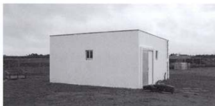
写真1 防水層耐風性研究のために建設した宮古島実測建物
