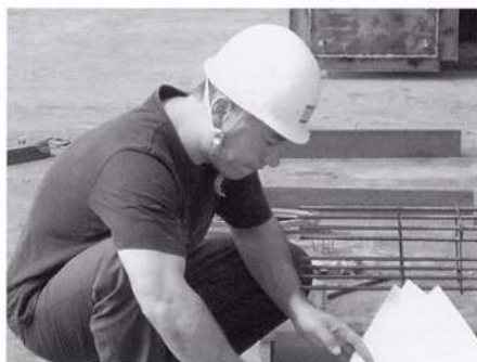
写真5 配筋検査するBotirjon君
