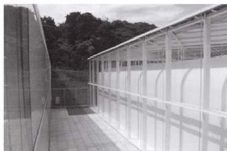
図7 ガラスの外壁と室内側の鉄板製断熱壁
