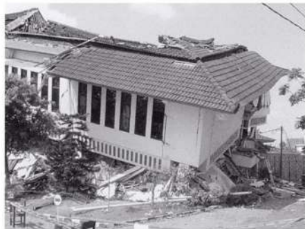
写真7 ジャワ島地震による建物崩壊
