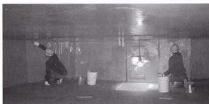
写真 施工状況
