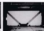
アンボンドブレース（設置例）
