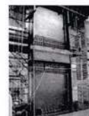
粘性制震間柱（設置例）
