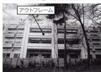
補強後の外観
