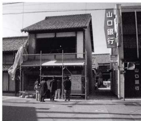
写真3 耐震改修する古い町家（山口県萩市）
