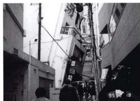
写真2 これは倒壊か（1995年阪神大震災の被害）
