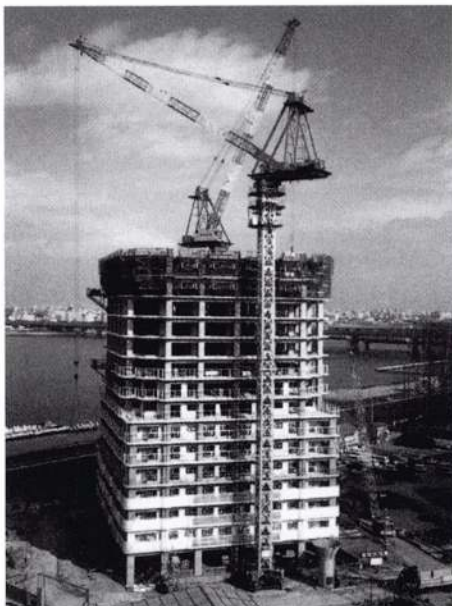
写真1 関西発のRC造超高層住宅（1988年施工中）
