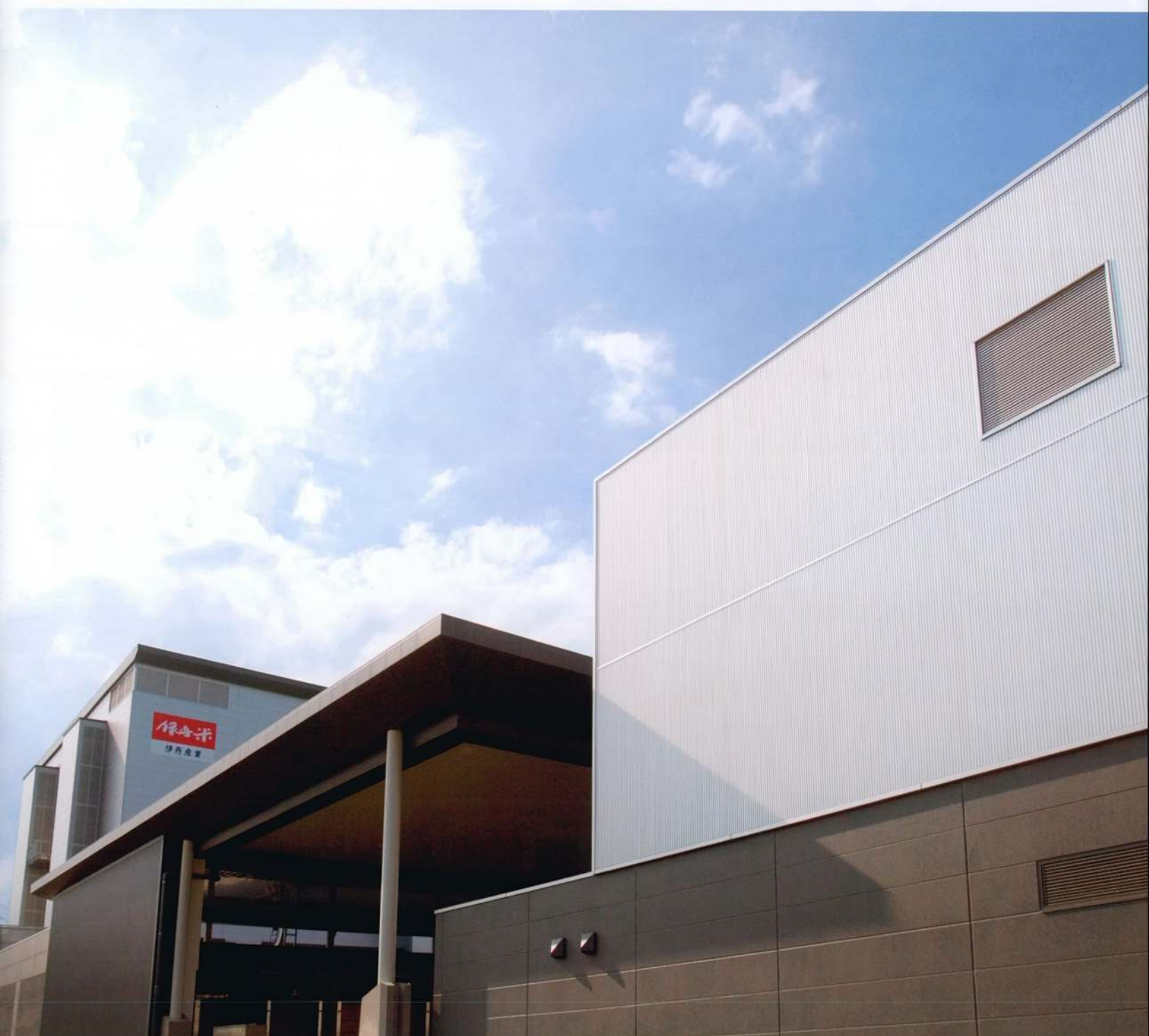
精米工場棟南側壁面には縦に繋がる給排気ダクトスペースを設け、建物の開口部を集約している。建物デザインは低層部をダークグレーとし、上部はスバンドレル、金属パネルのシルバー色を採用し、コントラストを利かせた建物色彩計画としている。
