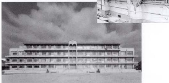
災害復旧事業により整備された学校 (右：復旧前)
