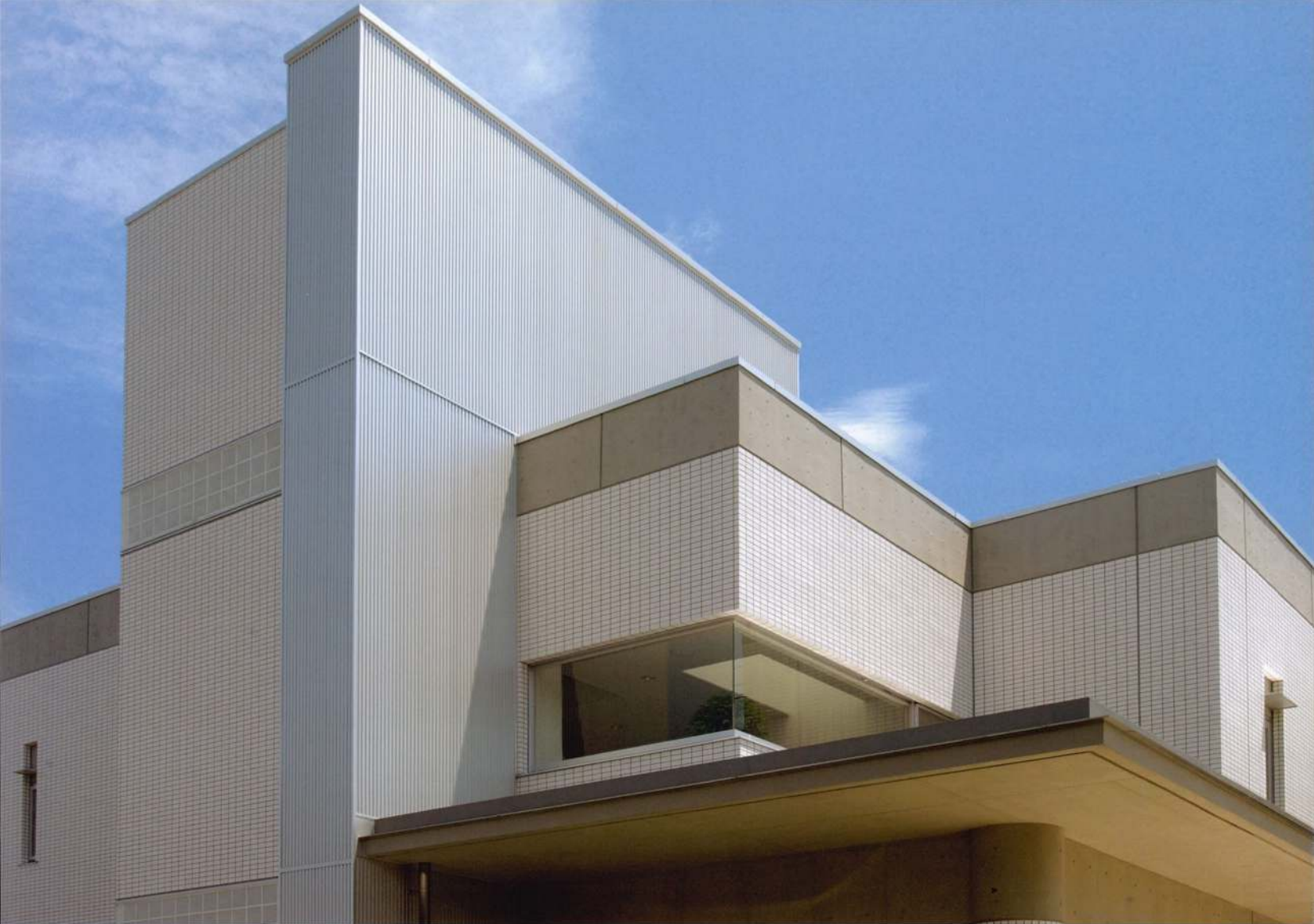
精米工場棟の建物デザインに呼応するような構成とした事務所棟。コーナーガラス部は、工場敷地内を一望できる見学ロビースペースとしている。
