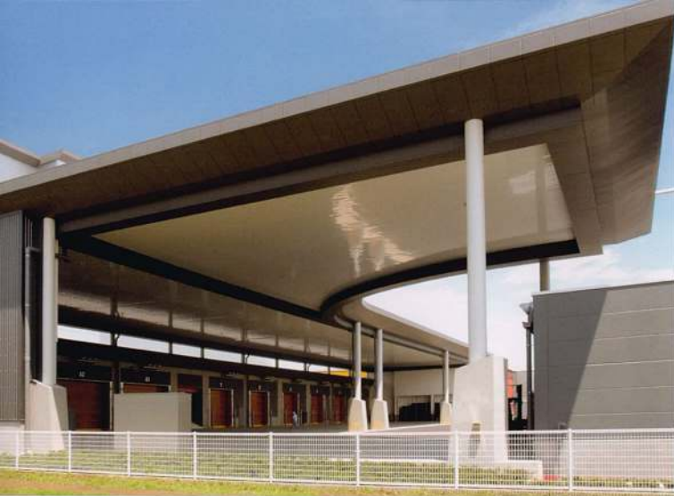
天井面をフラットに仕上げることで、防鳥対策に配慮したキャノピー。
