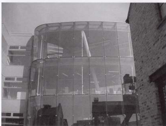
写真2 (右上) A Building in Camden 建設中 設計者 不詳
