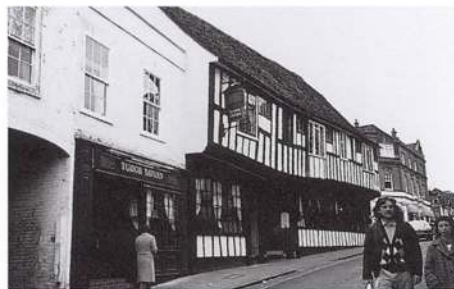
写真7 St Albans High Street 沿いの建築
