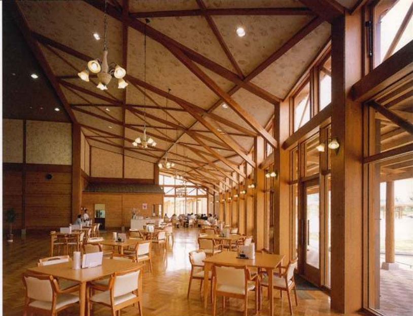
▲レストラン、鉄骨フレームに厚25の木板貼り、右窓外は噴水と中央広場
