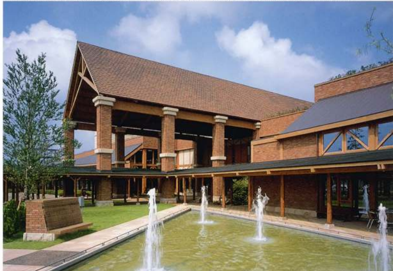
▲研修交流棟レストラン前の噴水側より
