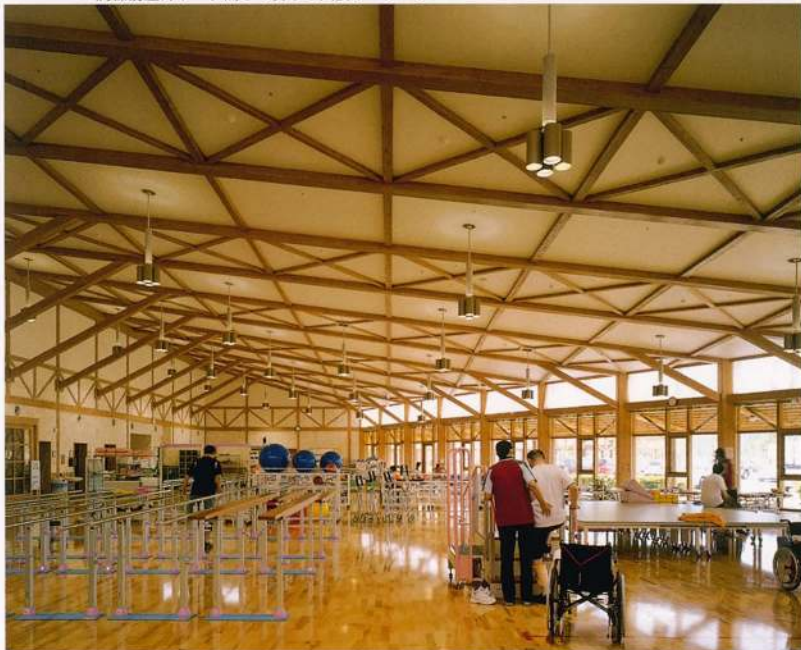
▲リハビリ訓練室、鉄骨フレームに厚25の木板貼り、サッシは木製
