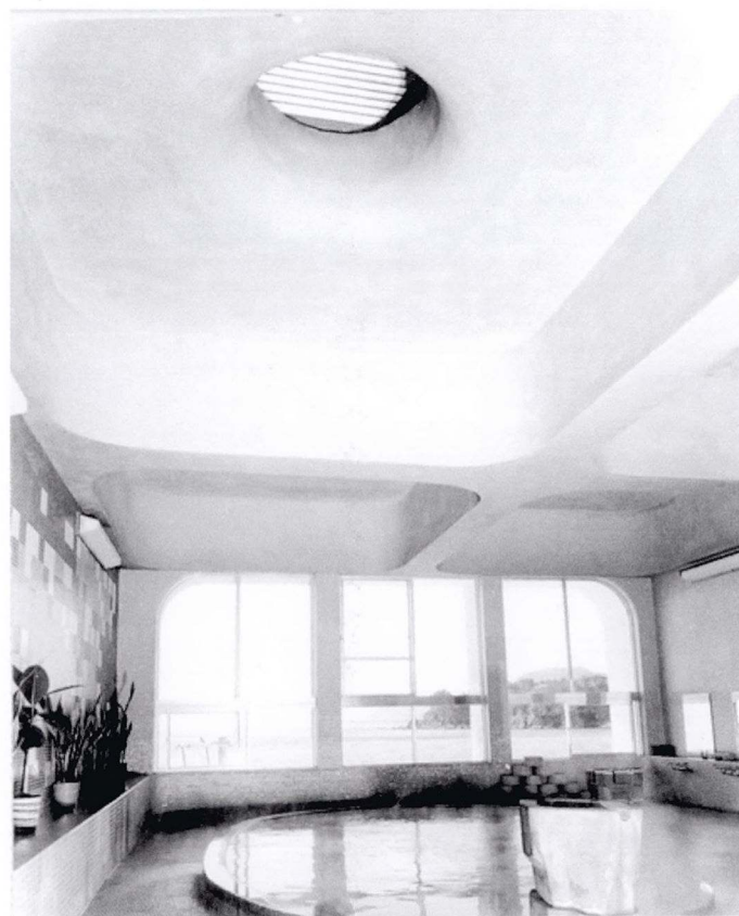
施工例2 吹付け石綿浴室天井
