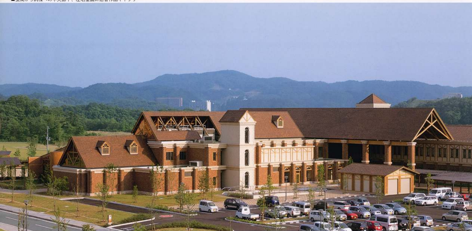
▲研修交流棟北面、右にモールと病院棟、手前は職員・来客用駐車場
