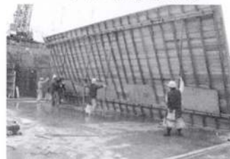
杉小幅板型枠建て込み状況
