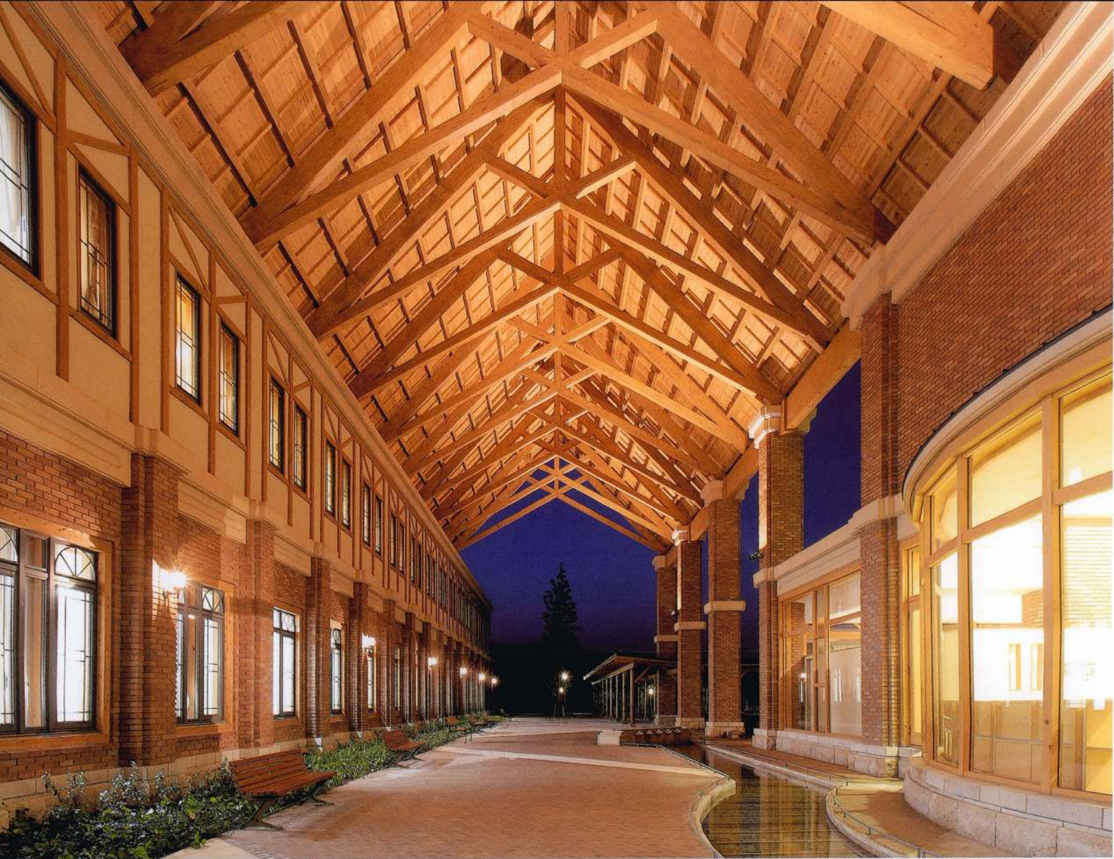
▲東西軸のモール、右研修交流棟、左病院棟、木造小屋耐火燃え代設計、煉瓦中空積外断熱(※)
