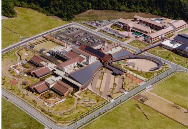
▲南側上空より見た医療健康福祉ゾーン、北東に養護学校とスポーツリハ（体育館・プール棟）※
