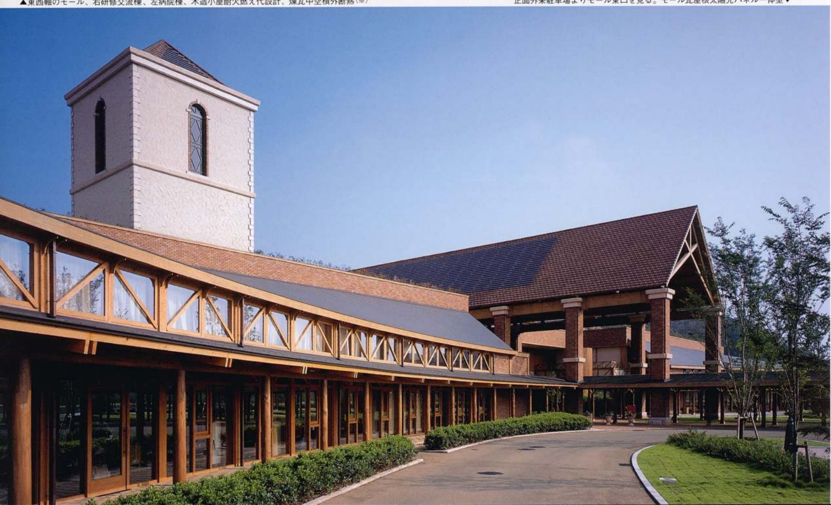
正面外来駐車場よりモール東口を見る。モール瓦屋根太陽光パネル一体型▼
