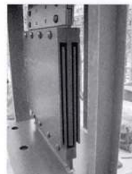
粘弾性ダンパー取り付け概要図
