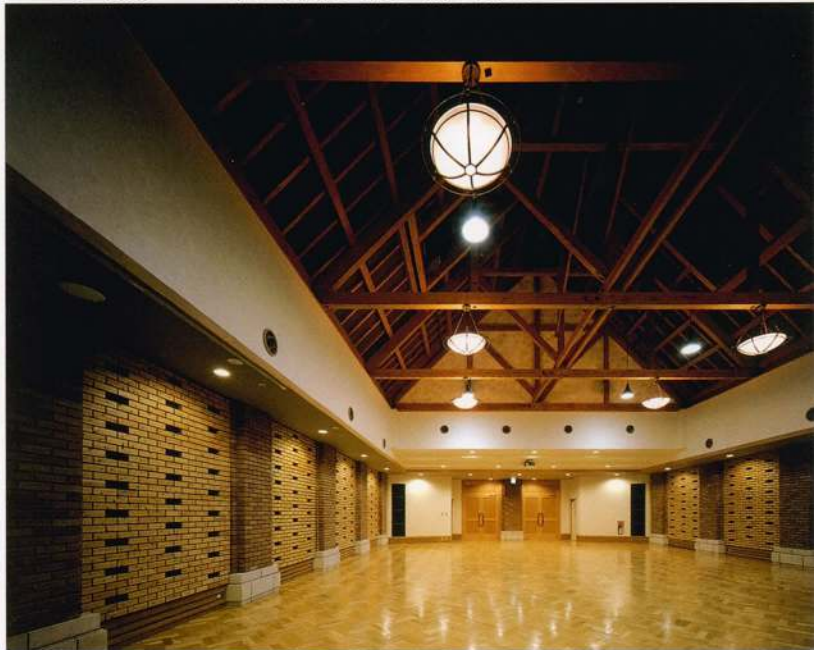
▲交流ホール、木造小屋組洋風在来工法、壁木レンガ目透かし貼り
