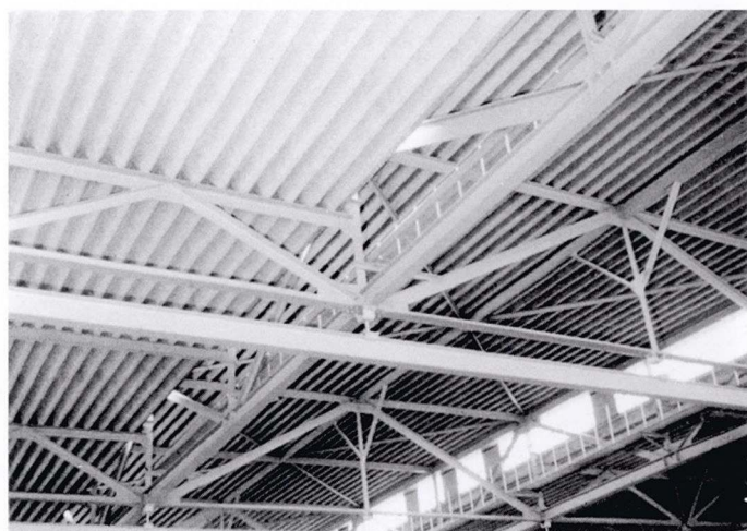
施工例1 吹付け石綿折板屋根裏
