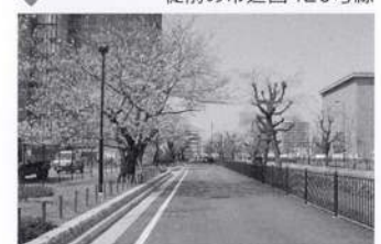
拡幅整備後の市道西420号線/保存桜の並木
