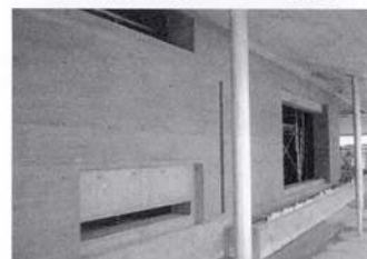
実施工における仕上がり状況
