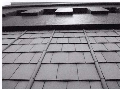
施工例：外装仕上材 大型セラミック
