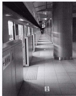
高輝度蓄光式避難誘導標識の設置例
