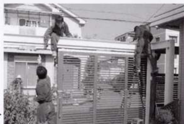
写真7 グループハウスペンキ塗り
