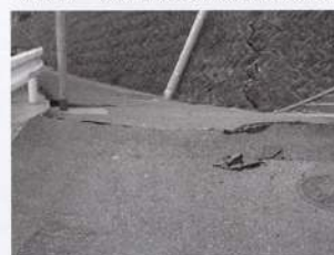
写真12 玄界中学校周辺の地盤
