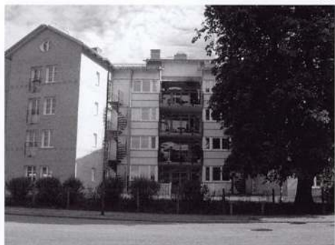
セルシウスガータン外観
