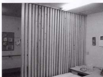
写真9 間仕切り完成!
