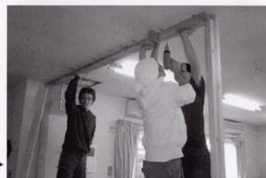
写真8 グループハウス間仕切り工事
