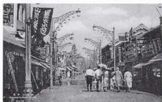
写真2 鈴蘭灯の敷設された元町商店街
