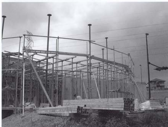
写真4 鉄骨無垢柱の建方状況
