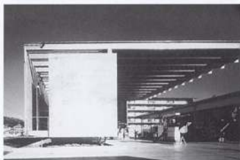
〔一般〕 おまかせくんショップ 静岡八幡サービスステーション 株式会社岩本弘光建築研究所
