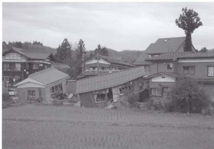
新潟県川口町田麦山地区の住宅被害
