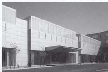
〔一般入賞〕 ローランド浜松研究所増築工事 大成建設株式会社
