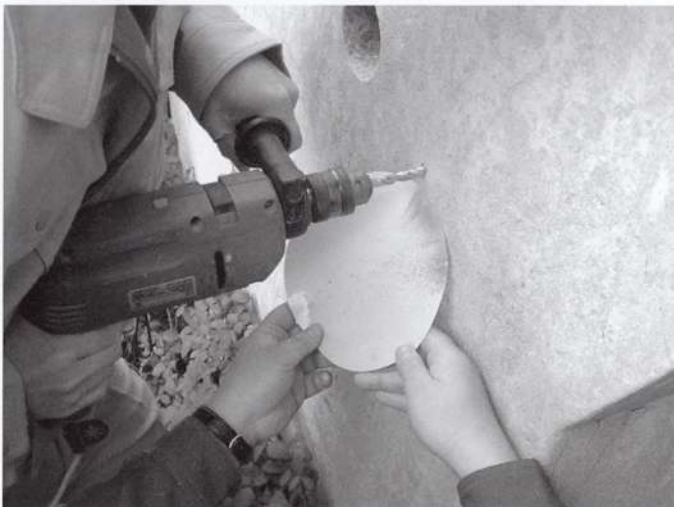
写真2 ドリル削孔粉による中性化深さの測定状況
