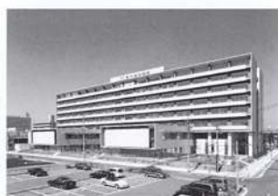
みなと医療生活協同組合協立総合病院 所在地/名古屋市中区熱田5番町 延床面積/26,958㎡ 竣工/2001年8月 設計/株式会社竹中工務店名古屋支店 施工/株式会社竹中工務店名古屋支店
