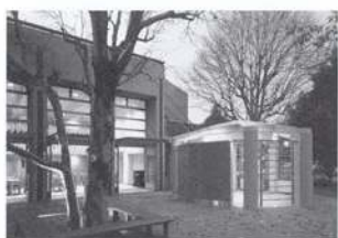
ライフパートナーこぶし 所在地/東京都東久留米市氷川台 延床面積/1,018㎡ 竣工/2000年11月 設計/株式会社建築設計事務所 施工/松井建設(株)
