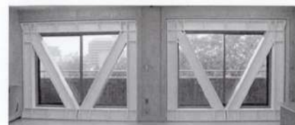
図5 鉄骨ブレース接着工法の施工例
