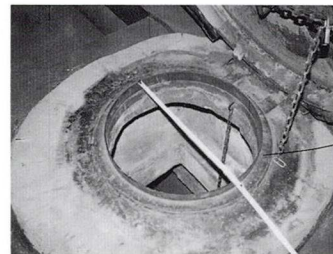
▲塔屋側からみたハッチの状況
