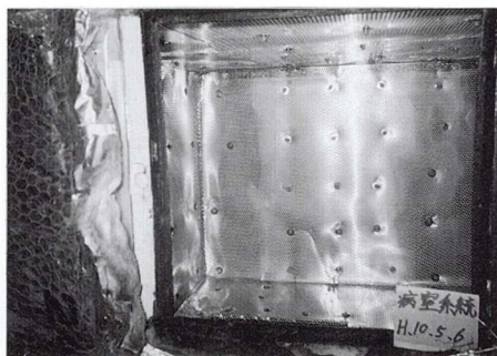
空調ダクト。チャンバー室の内張りはずれ （左側：施工前、右側：施工後）
