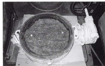
受水槽出口。バタフライ弁撤去
