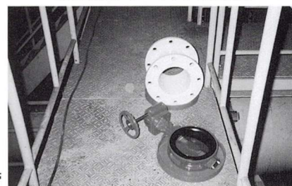
受水槽出口。バタフライ弁撤去
