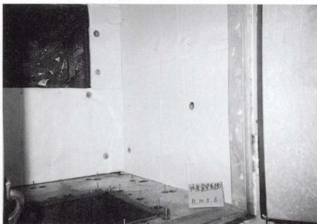
断熱防音処理中。スタッドボルト溶接
