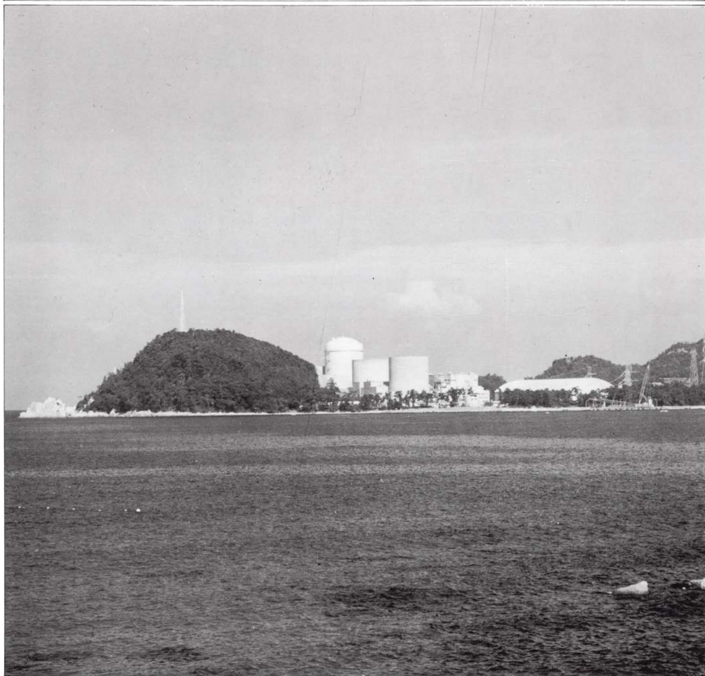
美浜原子力発電所
