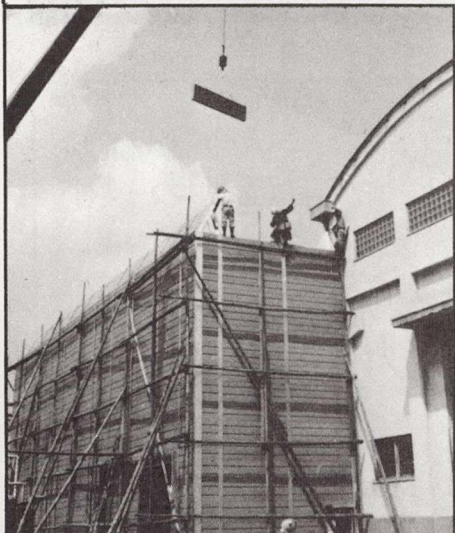
オリエンタル被覆鋼板製防音壁施工
