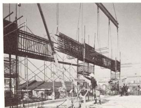
柱・はり組立鉄筋吊り込み
