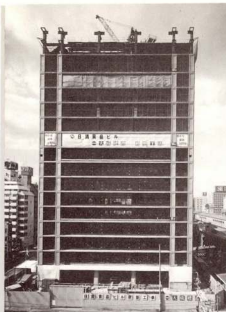
図-1 立面(施工中)
