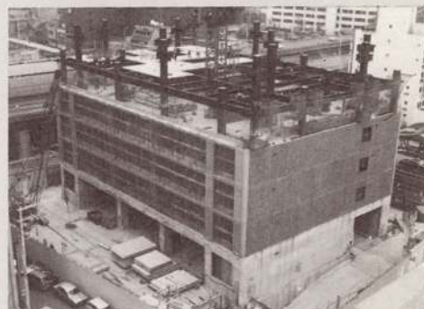
▲図-5 積層工法(施工中)
