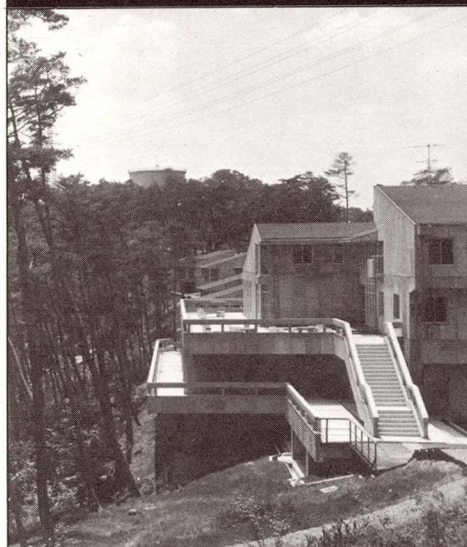
講堂予定地より本館を見る
