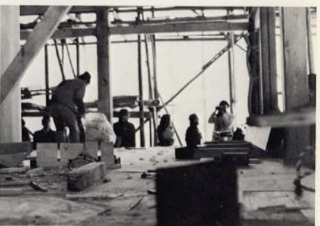
工事中の釈迦堂の見学
