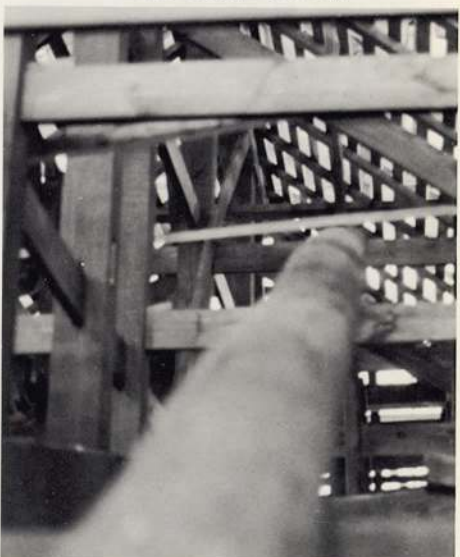
工事中の釈迦堂の内部
