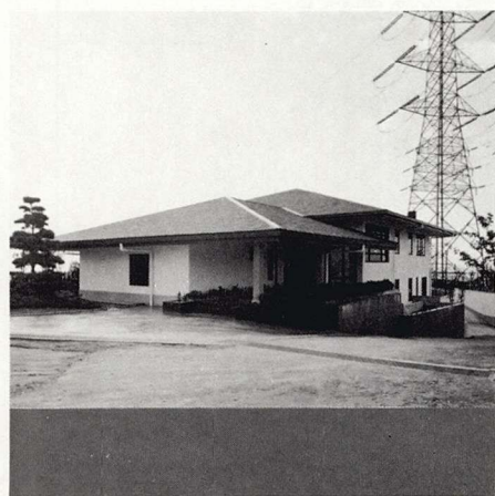
970. 出光興産(株)兵庫製油所御旅山会館
