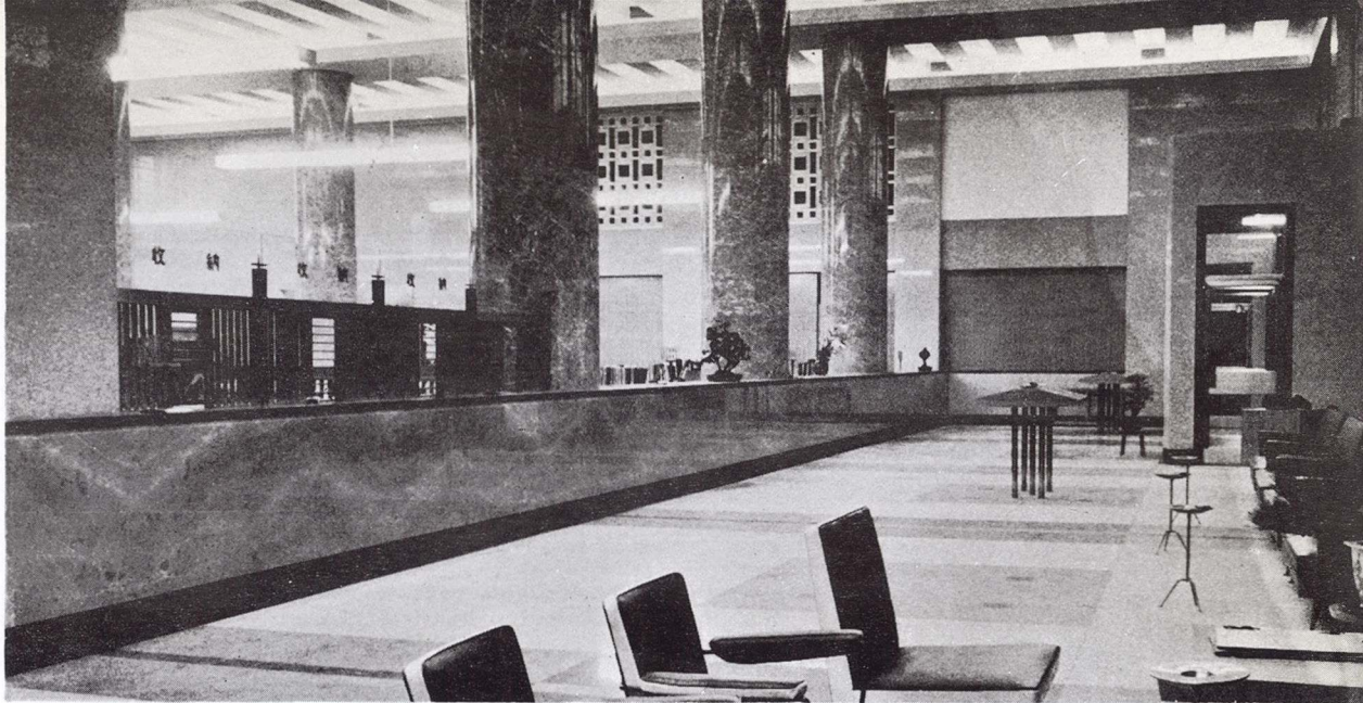
営業室 客溜床はテラゾー現場研出真鍮目地仕上で、黒、茶、ネズミ色の組合せ。柱及びカウンターは大理石貼仕上。柱（淡雪）、甲板（桑尾）、腰（蔵）、巾木（テラゾー桑尾）となっている。
