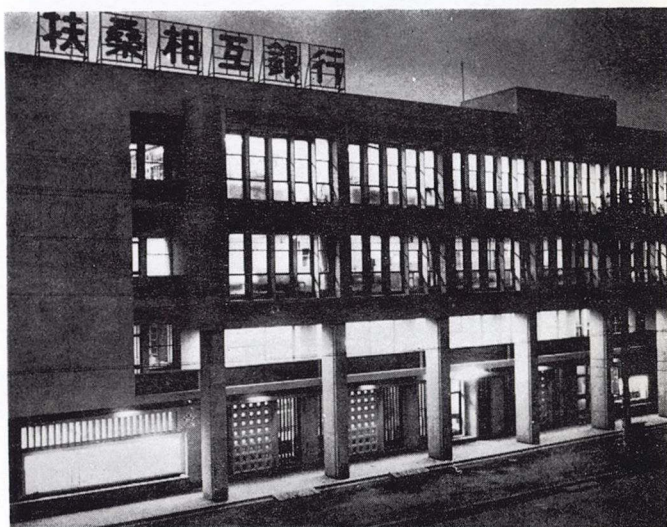
外観夜景 夜間、道路が暗くなり街の雰囲気に影響するというのが銀行の建物にはあり勝である。ここでは外部の照明の外に、内部の照明が外部に洩れて道路を明るくしている。
