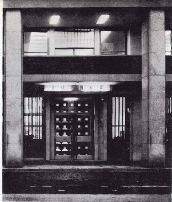
銀行営業室入口部分の夜景 営業室部分の外部仕上はテラカツストーン製ブレイキャストブロック積（ガラスブロック嵌込）と連動式ルーグアーの二つで構成されている。
