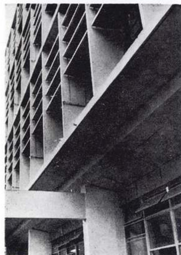
南西面・縦と横のルーバー
