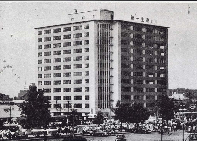
3. 第一生命ビルの外観（大阪駅前）設計者：竹中工務店
