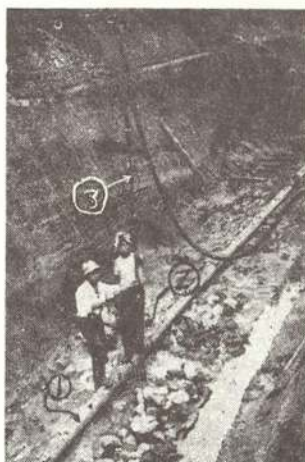
図-3 両総用水開渠部の Well point 設置状況
