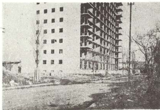
13. シカゴの旧市街の取毀された跡へ建築中の12階程のアパート
