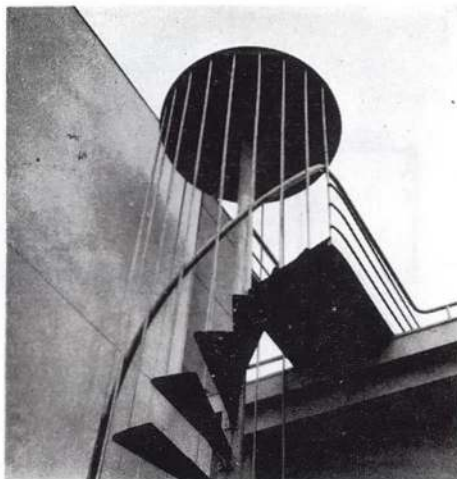
屋上への廻り階段
