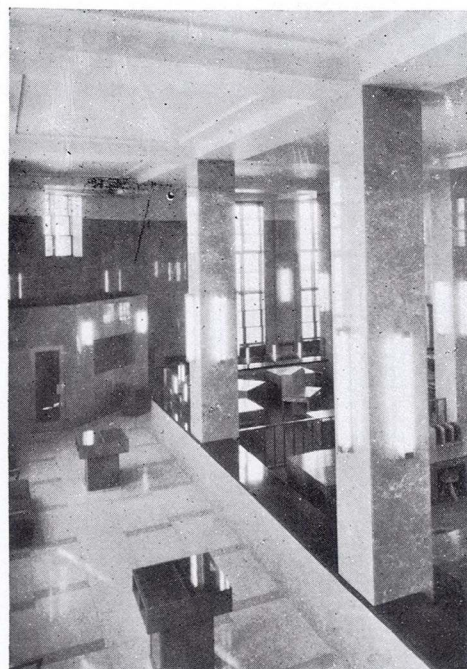
2階会議室から営業室・客溜を望む
