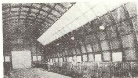
第2図 このパネルで家畜小屋を作つてある。 明るいので照明が少なくてすむ。
