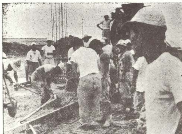
第2写真 床コンクリート打
