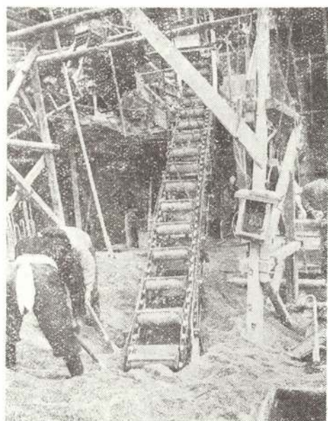
写真 6 図、砂揚げ竹中式バケツトコンベヤー
