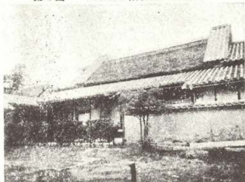
第4図 大和棟の落棟部と切妻壁
