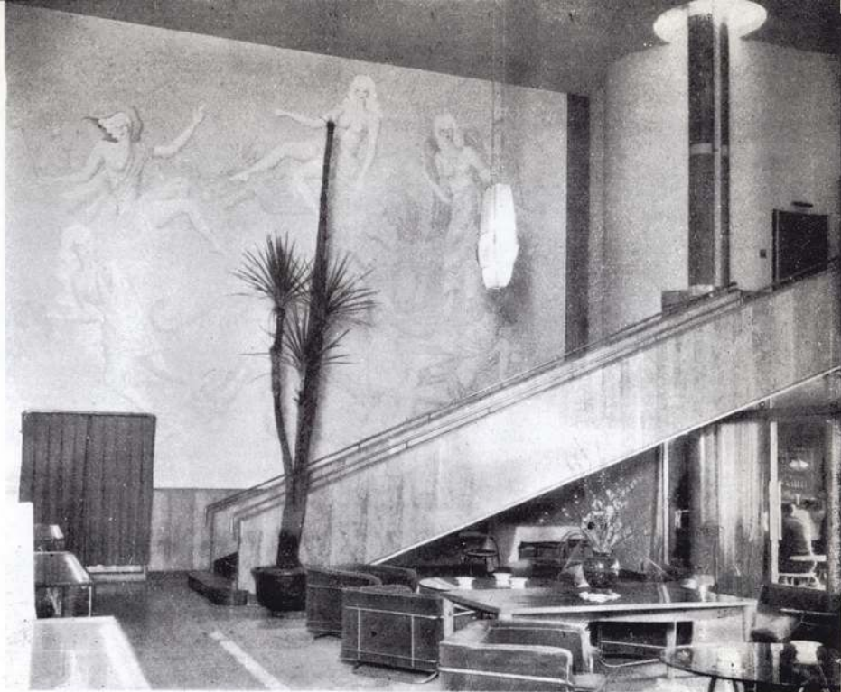
ロビー階を見る
