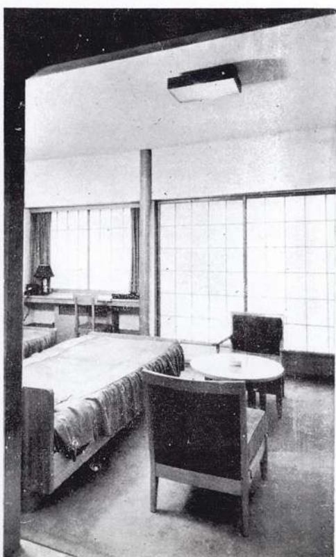
洋間寝室天井壁漆喰中塗り上 水性塗り造作材は塩地手前洋 服タンス、床檜フローリング
