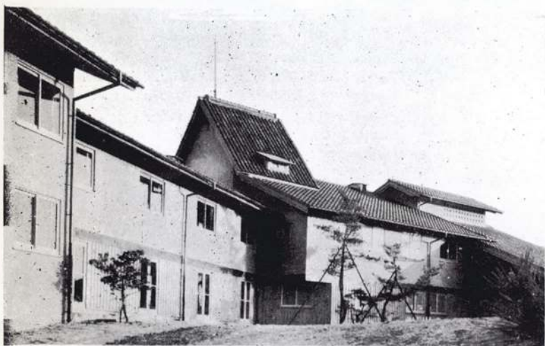
北面外観 道路より玄関ポー チに至る外観車道は北側を廻 り地下室のポーチに至る。
