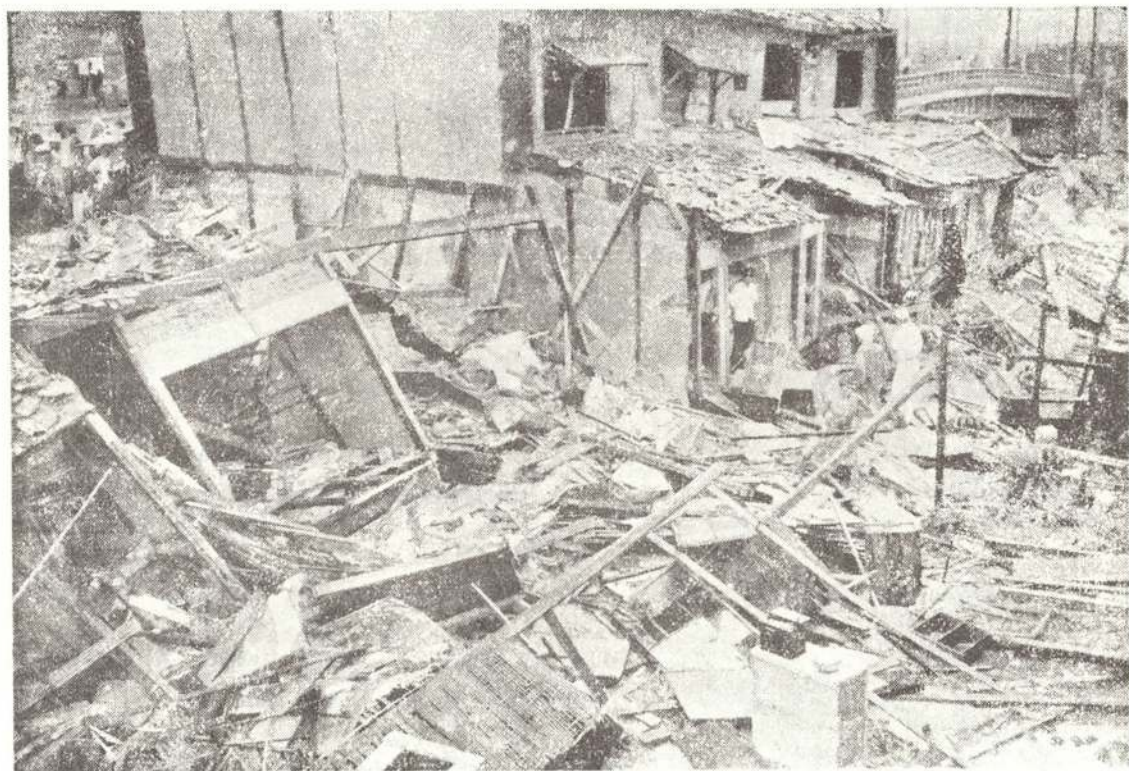
赤川町の倒壊建物
