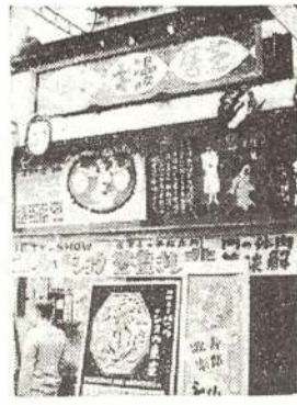
看板だけの建築(京橋)。
