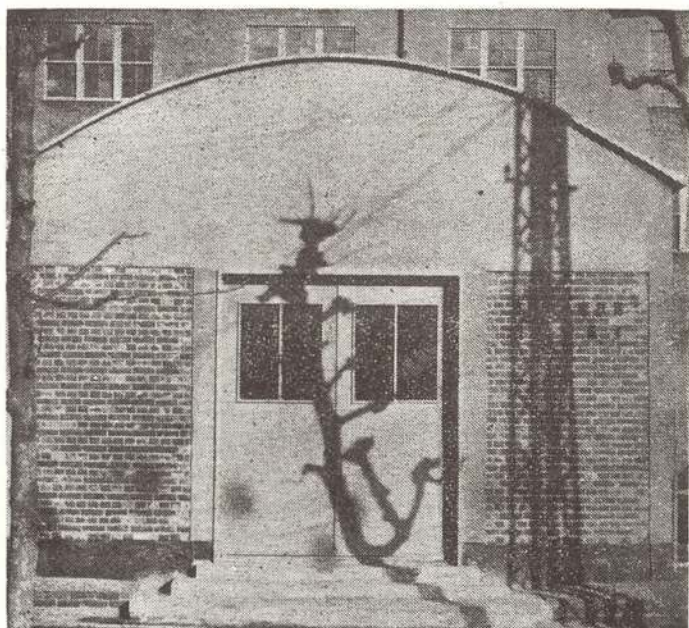
大阪電通局京都中央電話局電源室 日本ビルダースK. K 施工
