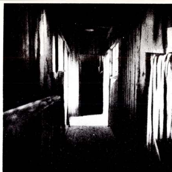
4. 2階廊下より3階への階段
