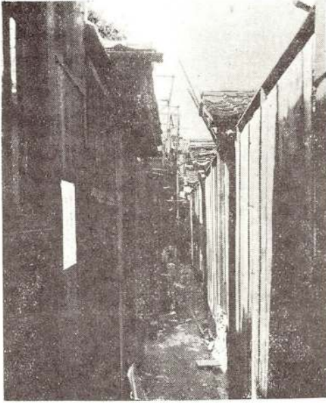
第9圖の1（改修前） 長屋裏側、5號、6號間便 所汲取専用通路に於ける在來 の板塀の狀況
