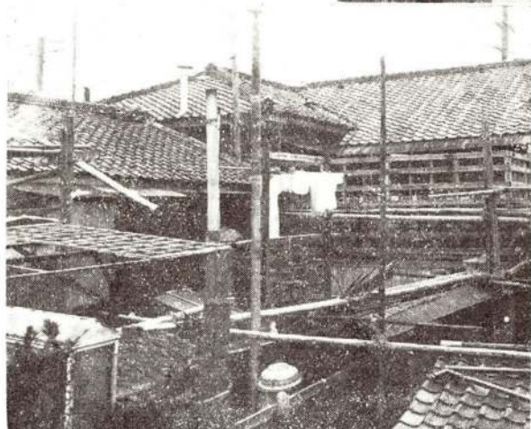
第6圖の1（工事中）
