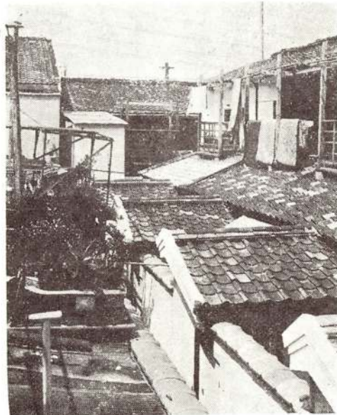
第9圖の2（改修後） 在來の板塀を塗塀（セメ ント瓦貼りの上「モルタル」 塗）に改修、便所蟻羽木摺 漆喰塗り仕上げの狀況
