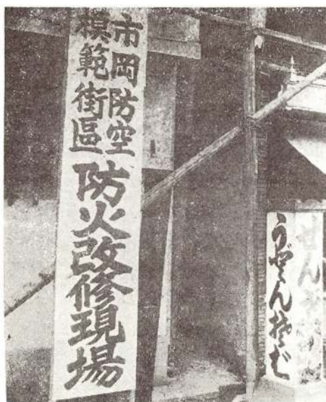
第4圖の1（工事中）
