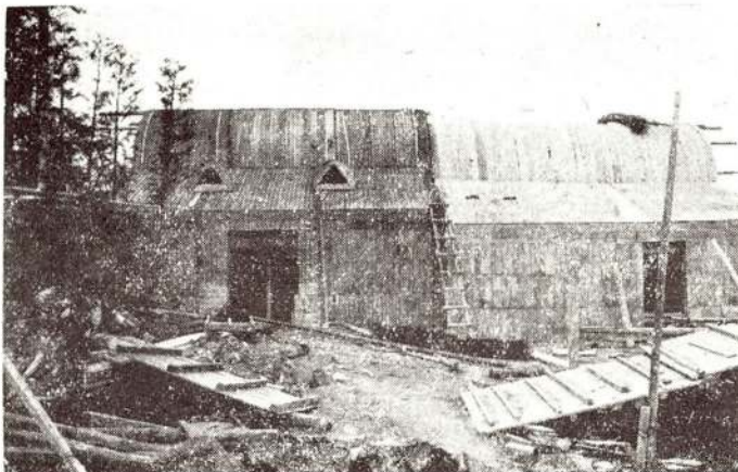
第2圖 モーラ式構成網貼付施工中
