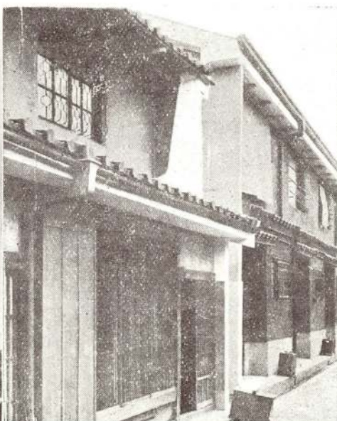
第7圖の2（改修後） 6號家屋一、二階袖壁新設、二階 軒裏木摺漆喰塗り仕上げ、7號家屋 一階袖壁新設、二階袖壁補修一階軒 裏木摺漆喰塗り仕上げの状況
