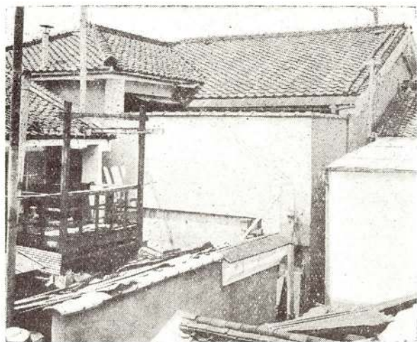
第6圖の2（改修後） 露臺周圍塗髹（セメント 瓦貼りの上「モルタル」塗軒 裏、蟻羽漆喰塗り仕上げ、 二階塀端に袖壁新設、3號 家屋軒裏漆喰塗り仕上げ、 妻部袖壁新設の状況
