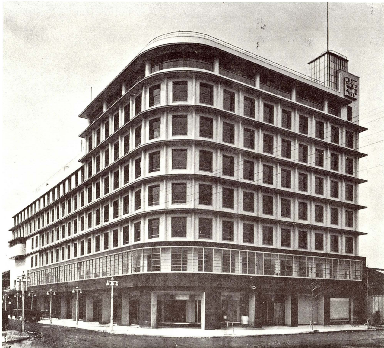
↑ 外観（御堂筋と平野町筋との角）
