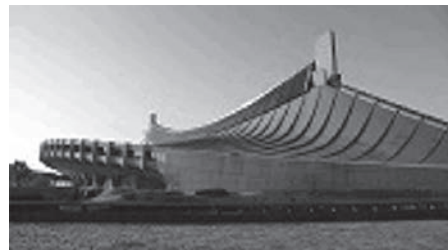
屋内総合競技場
