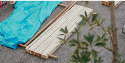
運搬時には丸棒に部材を集約させる
