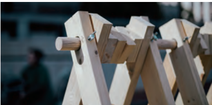
箱馬を噛ますことで部材間隔を調整するユニット
