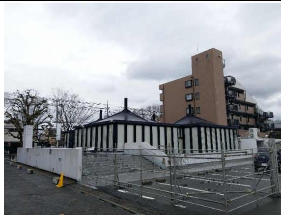
外観背面 アンブレラ・ストラクチャ 4つによる構成
