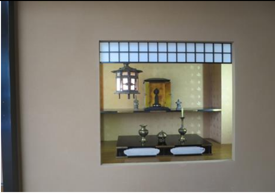
仏間は漆塗格子となっており 上げ下げ式となっている。
