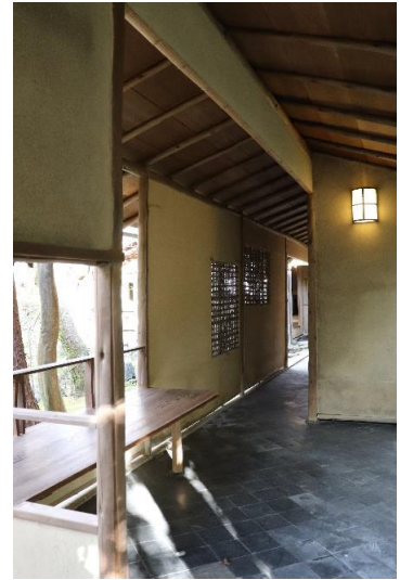
渡り廊下中間部の腰掛 床は敷瓦四半敷盲目地
