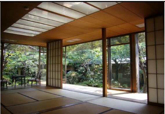
天井までの荒組子障子と埋め込み照明 庭側八畳は五分割、手前六畳は六分割の障子の割付
