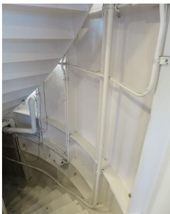
タワーの応力外皮構造がわかる階段室廻り
