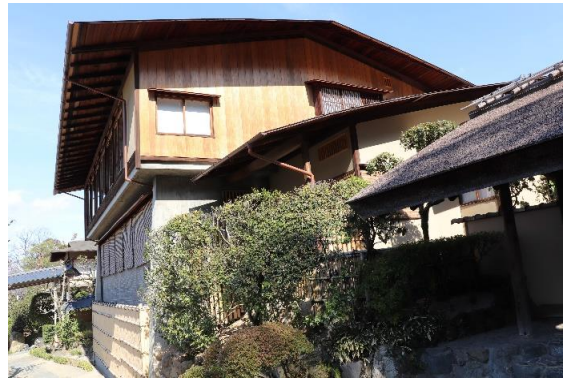
門脇にRC造の厨房＋木造の元宴会場棟（現客室）
