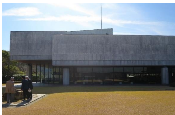
中庭からの外観
