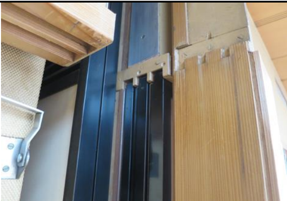
柱自体が回転して、大型襖が壁の中に 引き込めるようになっている。
