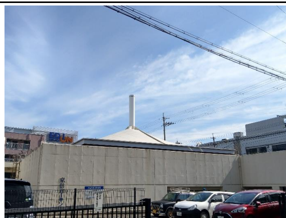
外観背面 RC壁面とアンブレラ・ストラクチャ
