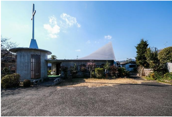
建物全景（東面）
