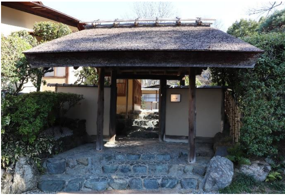
佳水園への野趣溢れる門 茅葺風だが桧皮葺（施工 中村外二工務店）
