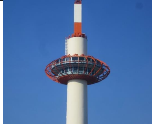
断面では楕円形の鉄骨フレームの展望室 平面では円形
