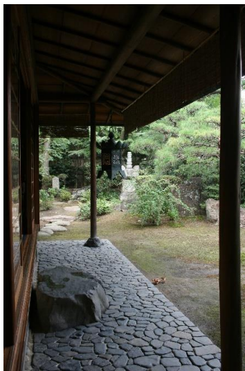
「看大」東側の土縁 見事な真黒石詰貼と真黒石沓脱
