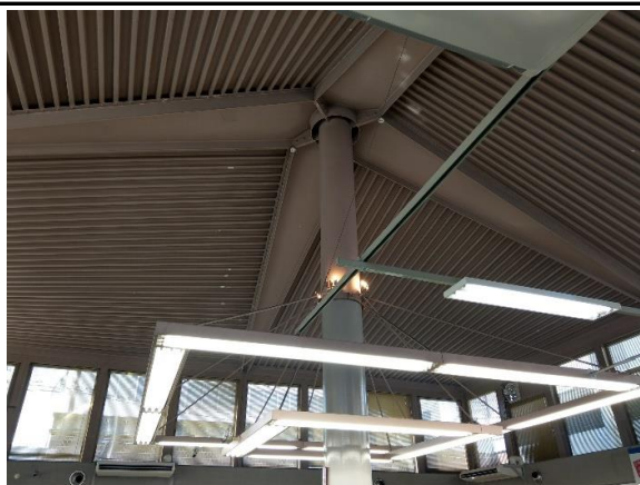
アンブレラ・ストラクチャ 丸柱と傘梁・HPシェルの屋根
