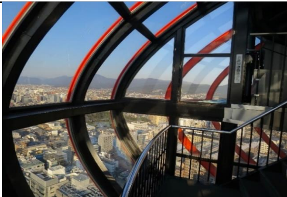
楕円形のボリュームが残る展望室階段部分 ガラスも楕円形に加工されている
