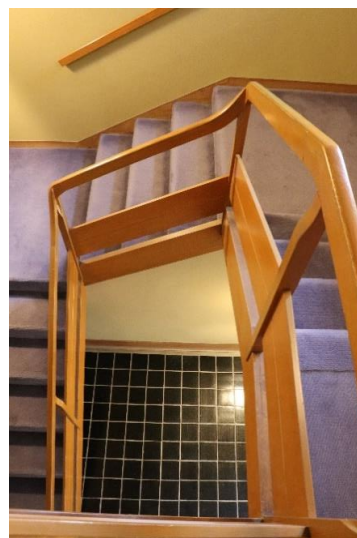
元宴会場と厨房を結ぶ主階段
