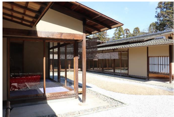
玄関ポーチからロビー、中庭側を見る 床、軒、棟高は低く、軒出は深く
