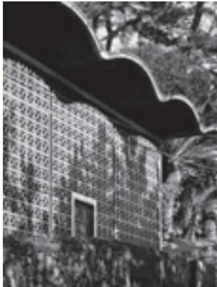
急斜面の裾を削り取るようにした姿は、建築というよりは土木構築物に近い。敷地で採取された花崗岩の壁が、波打つコンクリートスラブを伴って斜面に差し込まれたようである。竣工当時の資料にも、度重なる土砂崩れを阻止するため、擁壁代わりに建てたとある。
