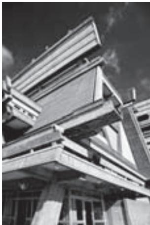
建築の表情は小口に集約されている。稲架（はざ）は、刈り取られた稲穂を木や竹組に掛けて構成される。一方の建築は、プレキャストパネルを斜柱に立て掛けて、バルコニーや樋を伴って妻側へ突出する。田畑において雨露は垂れ流せばよいが、建築ではそうは行かない。樋が、種々の要素を流れた雨を最後に受け、最も遠くへ張出す。過酷な環境に置かれた雨樋は、荒々しい現場打ちの表情を与えられ、建築に流れた歳月を物語る。
