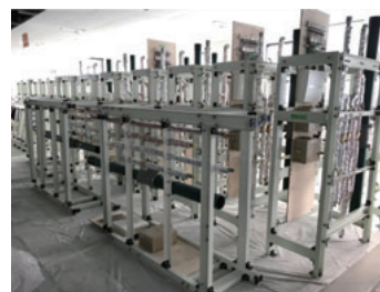
写真2 シャフト内配管のユニット化
