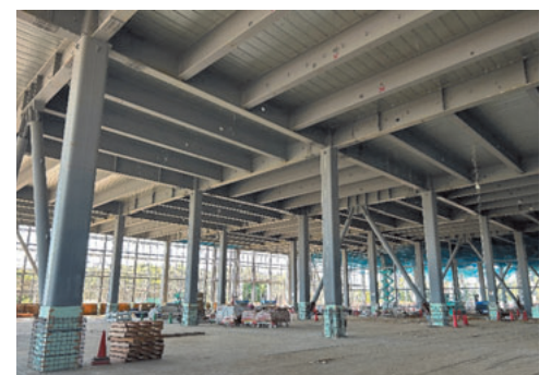
市松配置した鉄骨小梁
