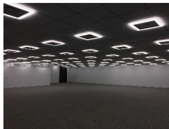
特注照明器具を配置したオフィス全景
