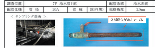
図1 冷水配管抜管調査
