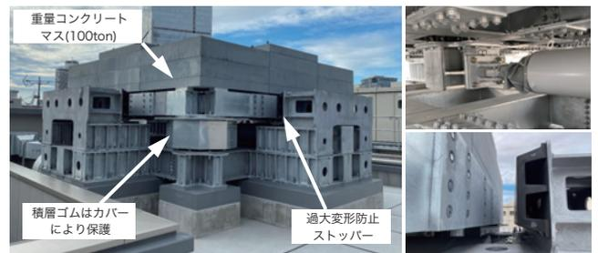
図5 地震用TMD外観(左)、オイルダンパー(右上)、防眩材(右下)
