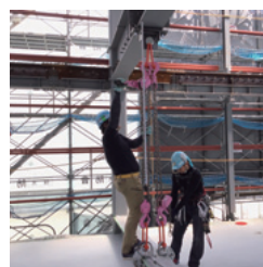
写真3 鉄骨大梁引張状況
