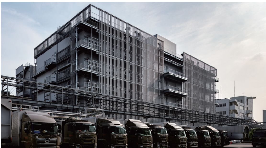
住友電工 伊丹製作所 研究新館
